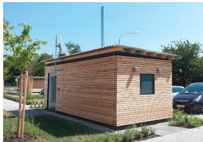
Lämmityskontti asennettuna parkkipaikan viereen (80 kW).
